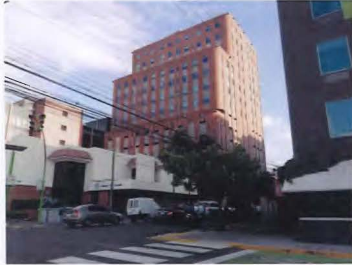
Imagen No. 2. Grupo de Seminario (2020), Congestionamiento Vial, Condominio Centro Corporativo Internacional, Avenida 6, Calle 26, Distrito Hospital, Cantón de San José, Provincia de San José.
