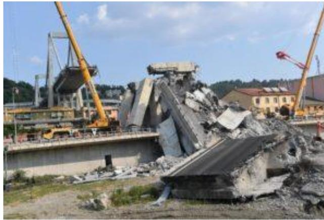
**Figura 1.** Vista del puente Morandi colapsado en el año 2018 debido a problemas de corrosión en Genoa Italia. Tomado de Global Resilience Institute at Northeastern University [4].
