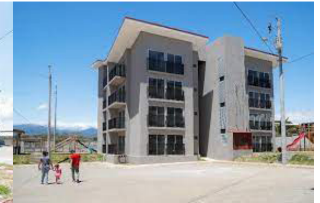
Imagen 5.22: Condominio La Arboleda, espacio común. Fuente: Tecnológico de Costa Rica. Observatorio de vivienda sostenible OVIS (2020)
