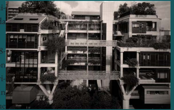
Imagen 2.8: Conjunto habitacional Next 21. Fuente: The Council on Open Building (2021)
