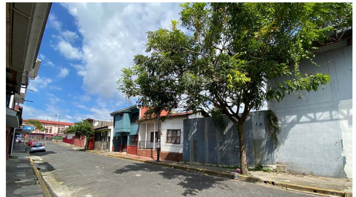
Imagen 6.22: Fotografía fachada oeste del lote seleccionado. Fuente: Rodríguez, N., Cambroner, V. (2023)
