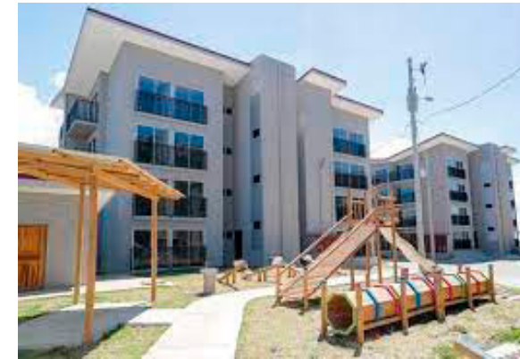
Imagen 5.21: Condominio La Arboleda. Fuente: Tecnológico de Costa Rica. Observatorio de vivienda sostenible OVIS (2020)
