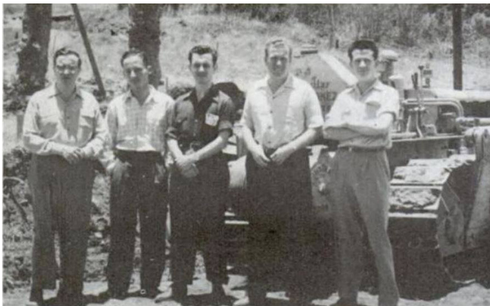
Imagen 2.48. Inicio de los trabajos de la Ciudad Satélite en Hatillo. Obras gestadas por Rodrigo Carazo como Gerente del INVU. Acompañan Alberto Di Mare, Efraín Morales, José Manuel Salazar, Bernardo Monge Otárola. 1955. Fuente Grupo Costa Rica antigua vista por el lente fotográfico de la Historia.
