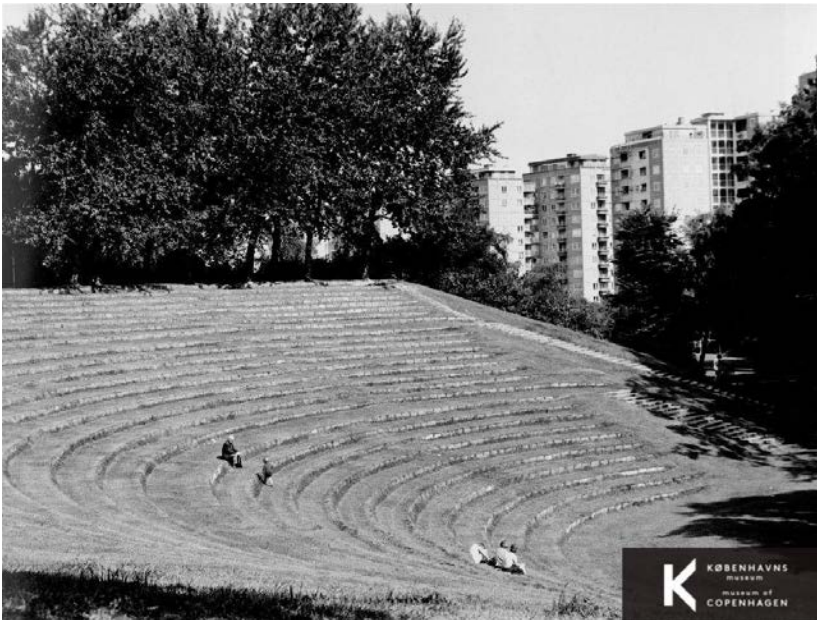
Imagen 2.110. Gran anfiteatro construido con la tierra sobrante de las excavaciones. El escenario fue inaugurado en 1953 y tiene capacidad para 2.000 espectadores sentados. Fotografía de 1970. Fuente: Copenhagen City Archives.
