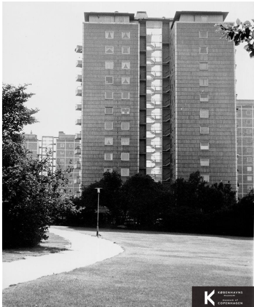
Imagen 2.108. Composición de edificios gemelos, unidos por un bloque de escaleras en vidrio. Fotografía de 1970. Fuente: Copenhague City Archives
