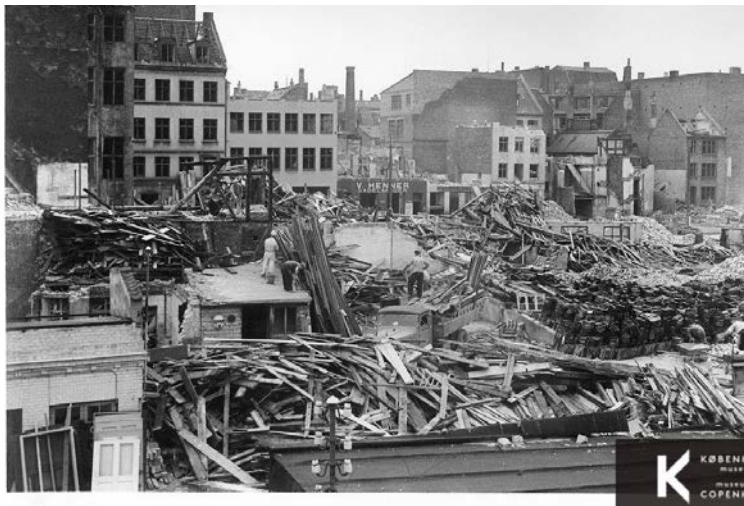
Imagen 2.97. Demolición en Adelgade del edificio 64, 66 y 79. Fuente: Copenhagen City Archives.
