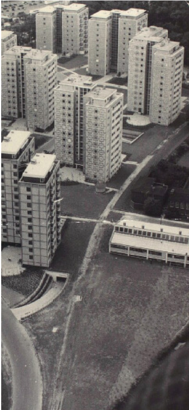
Imagen 3.28. Vista aérea de la construcción de Bellahøj. Fuente: Rosenberg et al. (2015)
