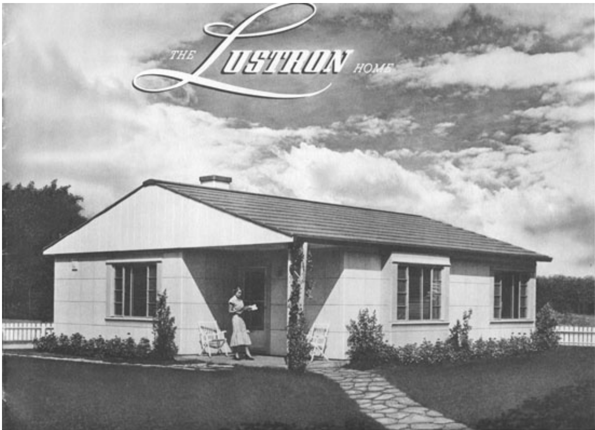
Imagen 2.3. Casa Lustron, casa modular que se armaba con paneles ensamblables, fácil y rápido. Fuente Arquine.
