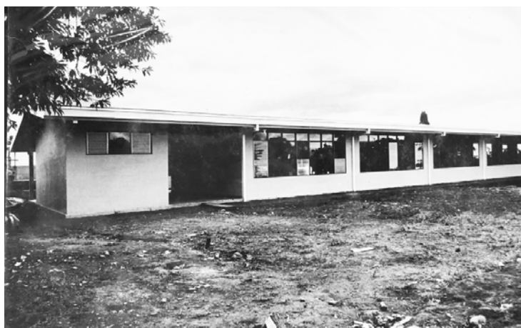
Imagen 3.8. Fotografía del proceso de construcción del edificio de la Escuela de Hatillo, San José, 1956. Tomada por el MOPT. Fuente: Archivo Nacional.
