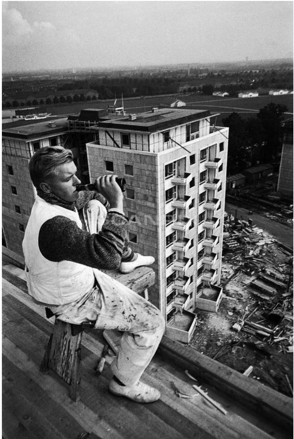
Imagen 5.2. Constructor en la azotea de uno de los edificios de Bellahøj, tomándose una cerveza, década de 1950. Fuente: Engels. P
