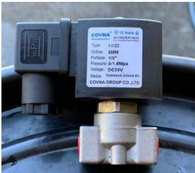
Figura 58: Válvula solenoide para la inyección de gas, tomada en San Rafael, Escazú, San José, Costa Rica. (elab. propia)
