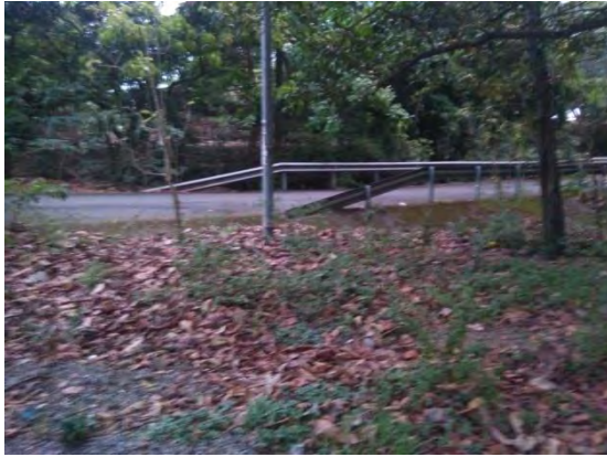
Fotografía 14: Rio Pacacua contiguo al puente 80 .
