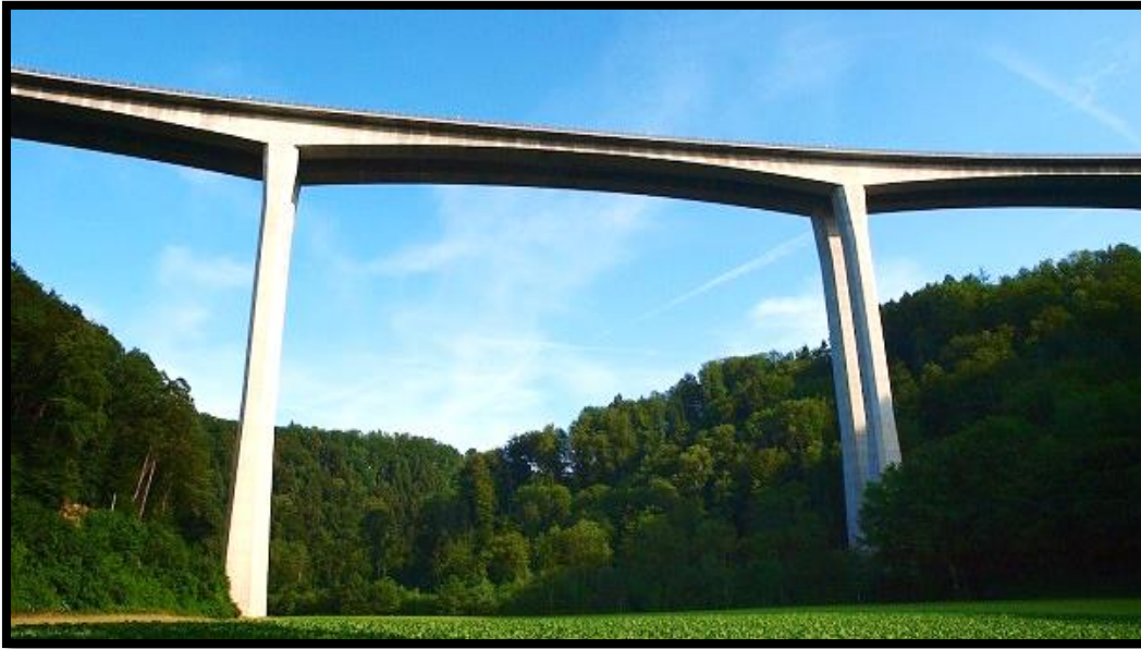
Figura 2-3. Puentes gemelos Mentue en Suiza Fuente: Burdet&Zanella, 2000
