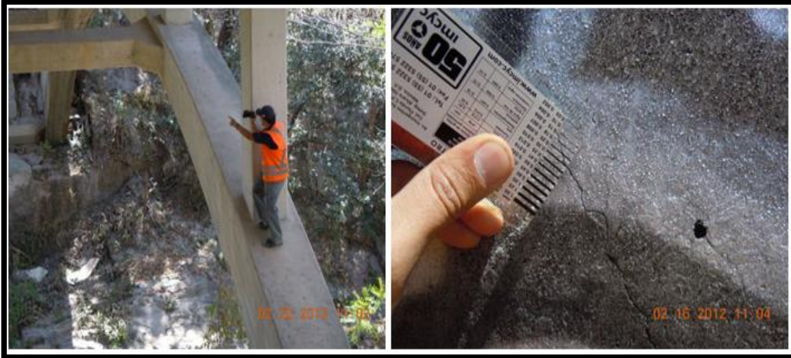
Figura 1-2. Inspección visual de puentes Fuente: LanammeUCR.; 2013
