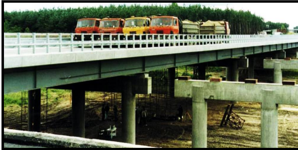
Figura 2-8. Ensayo de carga estática sobre el puente del río Drweca Fuente: Ozagul, Caglayan, &Uzgider, 2009
