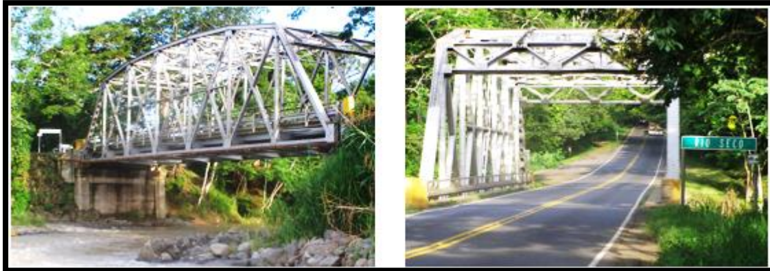
Figura 4-32. Vista lateral y principal del puente sobre el río Seco Fuente: Liu-Kuan, Aguero-Barrantes, Barrantes-Jimenez, & Loria-Salazar, 2016
