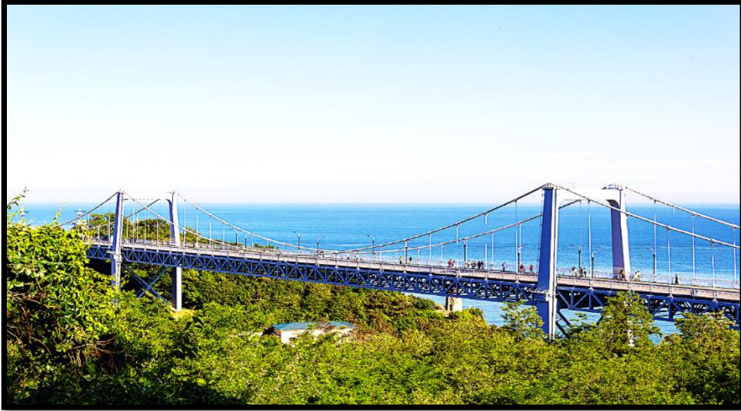
Figura 2-11. Puente sobre el río Dalian en China Fuente: Yu, Liu, Li, Mao, &Ou, 2013
