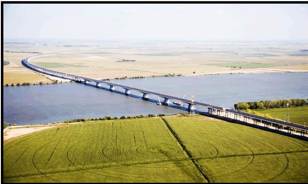
Figura 2-12. Puente Leziria sobre la autopista A10 en Portugal Fuente: Sousa, Cavadas, Henriques, Bento, &Figueiras, 2013
