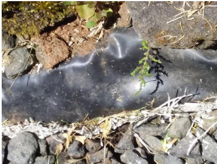
Figura 4. Plástico negro que recubre los tanques de las biojardineras para evitar infiltraciones en el suelo. Biojardinera Zapote, San Mateo.
