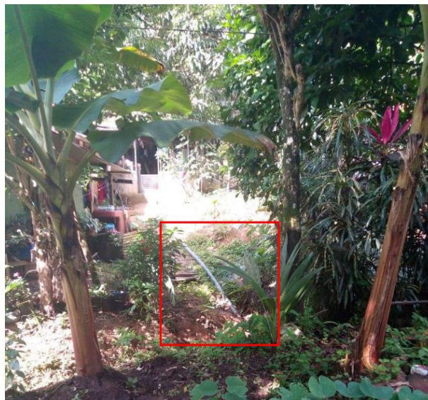
Figura 44. Tubo para vertido de aguas residuales que se dirige a la quebrada El Mono
