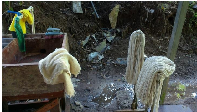
Figura 42. Tuberías de aguas grises que desembocan en el terreno de forma superficial. Evidencia de estancamiento de aguas jabonosas en zonas de lavandería.
