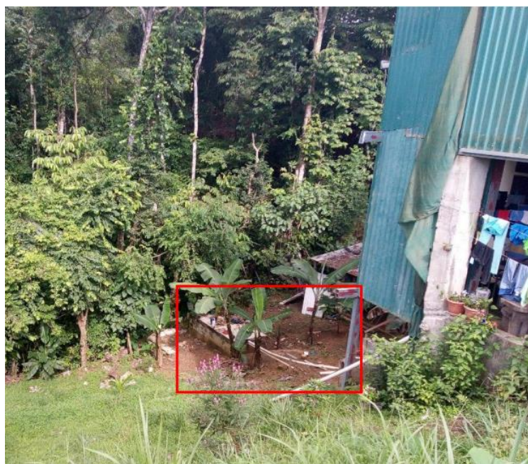
Figura 46. Presencia de tanque séptico en la ribera de la quebrada Don Carmen
