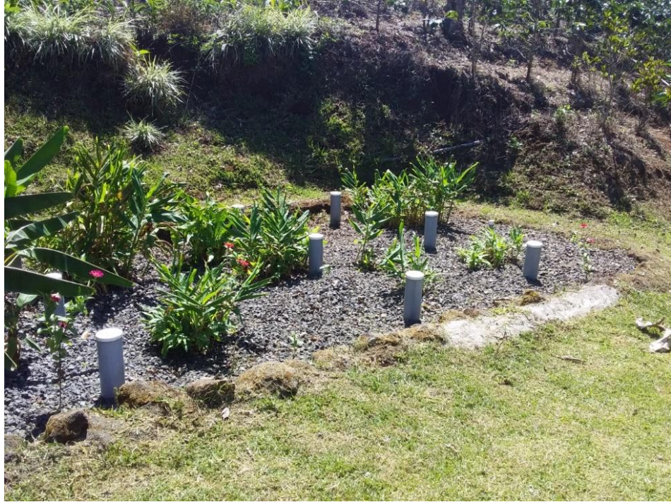
Figura 5. Tanque de biojardinea con aireadores y grava. Biojardinera Zapote, San Mateo.
