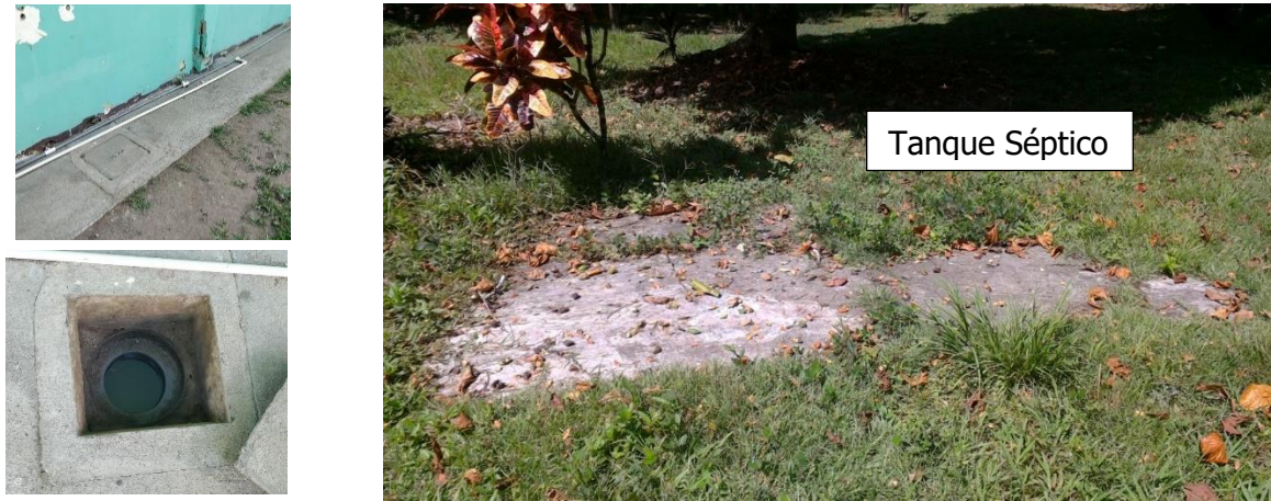
Figura 38. Cajas de registro de aguas grises, que se conectan con el tanque séptico
