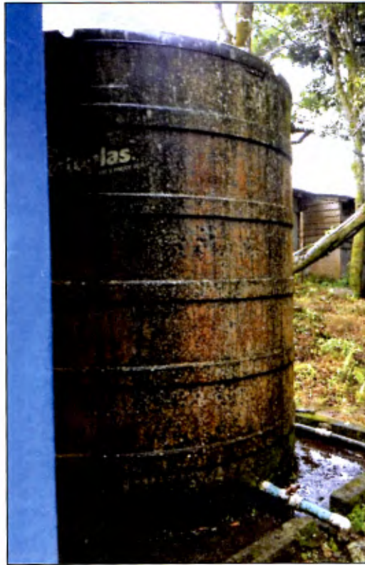
Figura III.60. Tanque de almacenamiento de plástico de La Cruz
