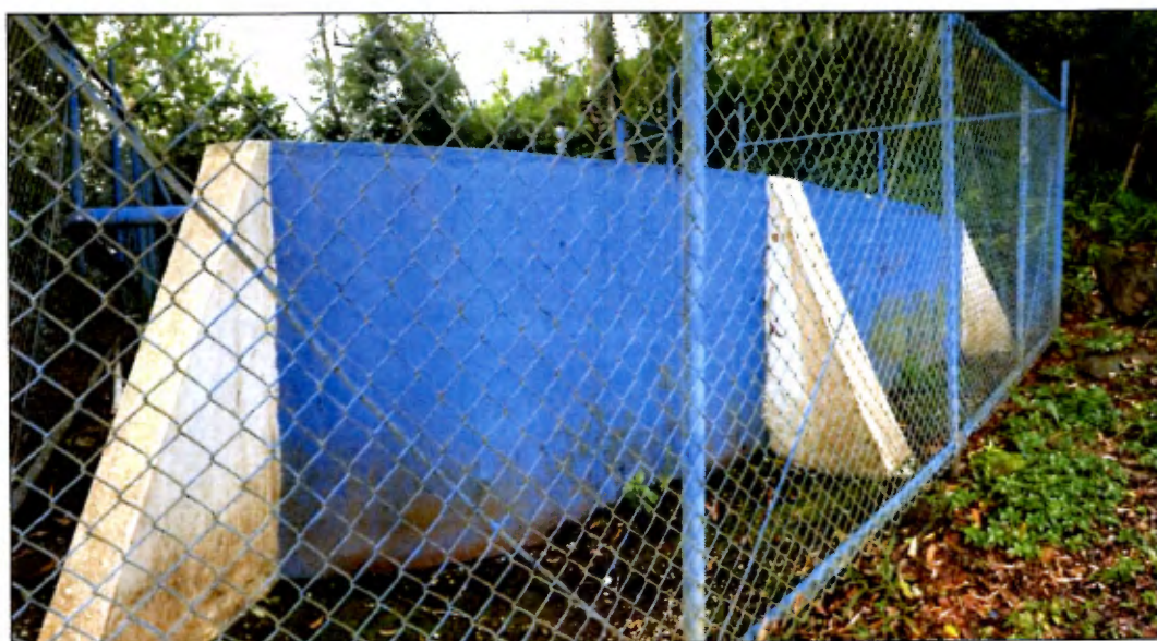
Figura III.54. Tanque de concreto de San Rafael
