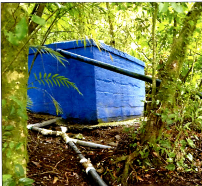
Figura III.53. Tanque de concreto por la naciente de San Rafael
