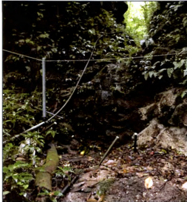
Figura III.58. Captación 1 de La Cruz
