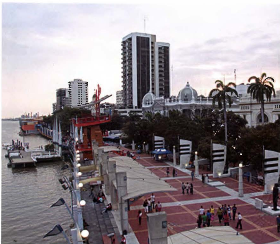
Fig. 7.1: Proyecto de regeneración urbana del antiguo Malecón Simón Bolívar, Guayaquil, Ecuador. Fuente: latinamericastudios.org
