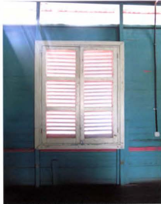
Fig. 23.2.6.3. Detalle de cerramientos en madera y cedazo en vivienda vernacular. Fotografía captada por la autora.
