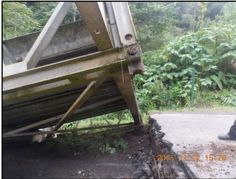
Figura 24. Vista lateral del levantamiento del extremo del puente sobre el Río Cataratas Fuente: (LanammeUCR, 2015)
