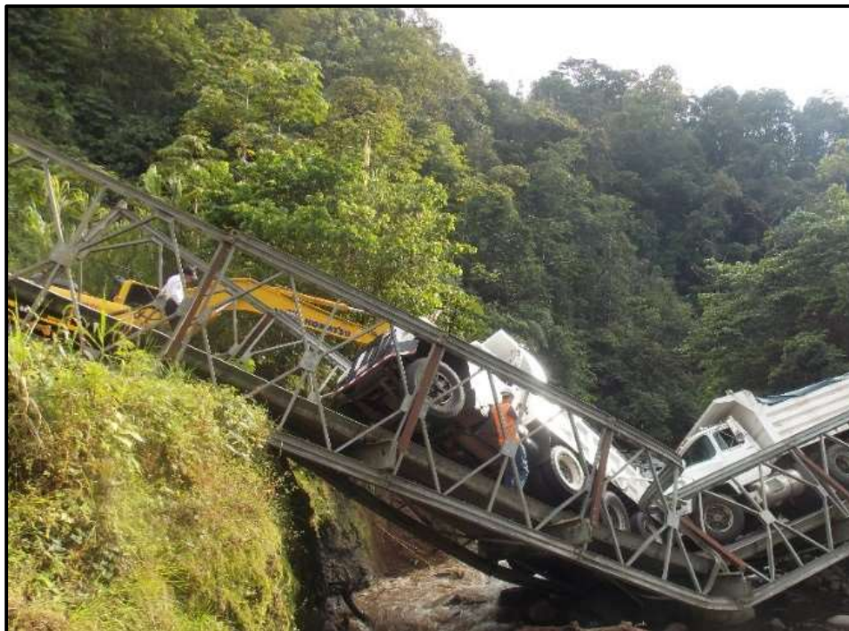
Figura 61. Riostra exterior: Puente Río Cataratas Fuente: (LanammeUCR, 2015)
